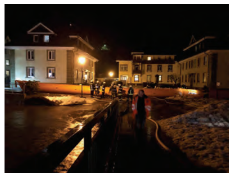
Aufbau des mobilen Hochwasserschutzdamms in St. Blasien. Bild: LRA Waldshut.
