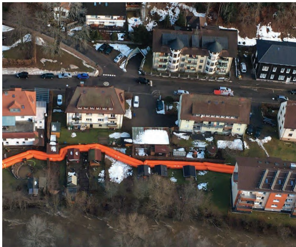
Der mobile Hochwasserschutzdamm im Einsatz in St. Blasien. Bild: RP Freiburg.
